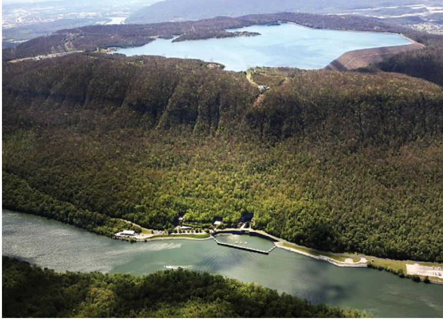
Σχ. 2. Σταθμός αντλιοσταμείωσης 1652 MW στις ΗΠΑ [3].
