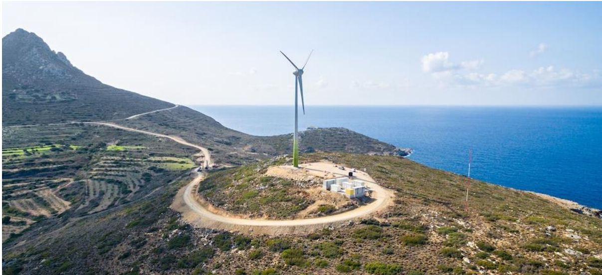
Σχ. 15. Α/Γ και μονάδες συσσωρευτών υβριδικού σταθμού Τήλου [39].
